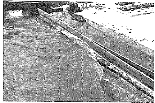
写真-4 テトラ消波工への波の作用状況
