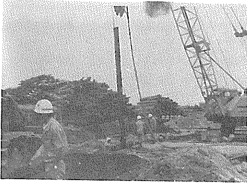
図 3・30 引き抜き鋼矢板
