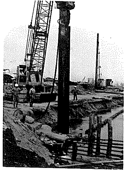
鋼矢板の引き抜き (富山港—3.0m 物揚場、11年経過)
