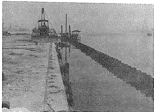
図3・4 -3.0m物揚場の外観(富山港)
