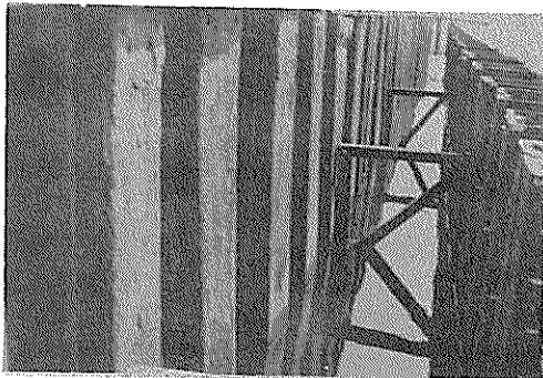
図 2・15 下北埠頭-5.5 m 岸壁の海水面上鋼矢板面(1) No.12 付近より No.2 を望む(40 年経過)
