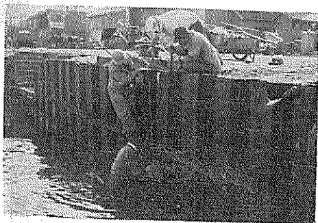
写真-7 留崩港, 南岸壁
