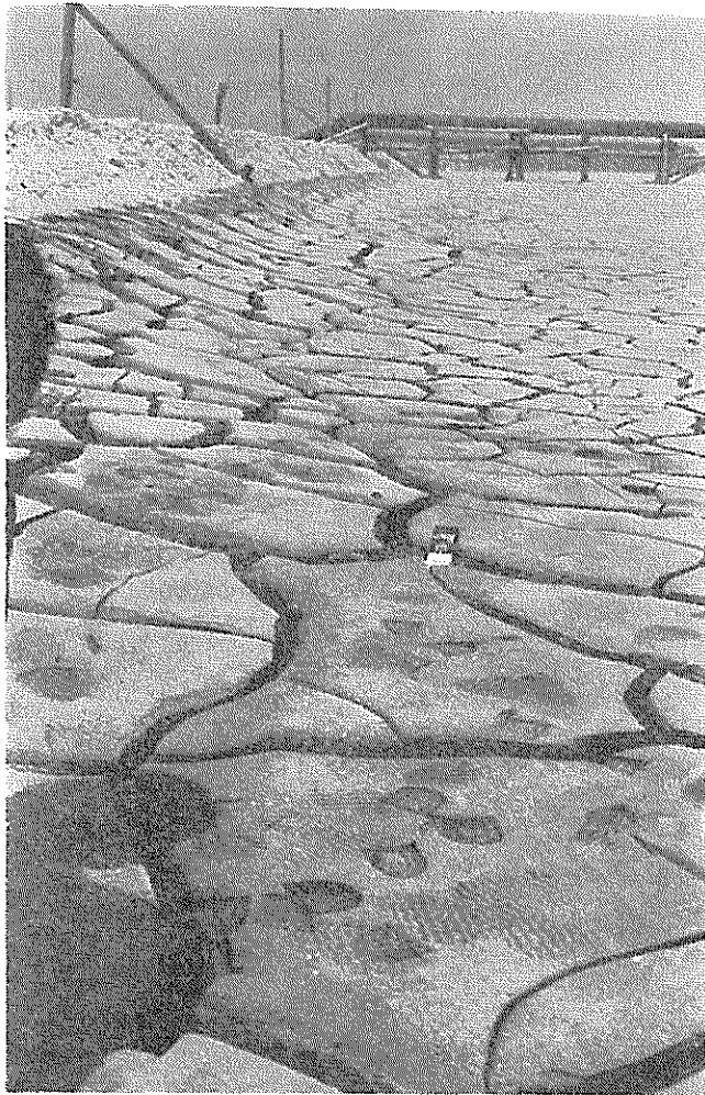
軟弱粘土による埋立地の築堤付近の表面乾燥状況（埋立後 4 ヶ月）
