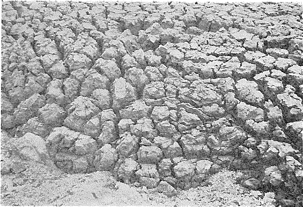
押し出しによる隆起粘性土の乾燥状態
