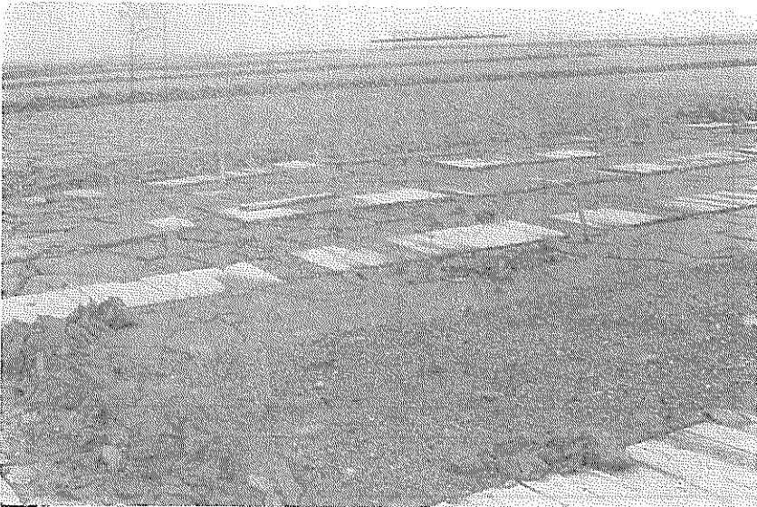
写真一七 前方敷砂およびペーパードレーンのみ 軟弱粘土による埋立土の表面処理試験工事
