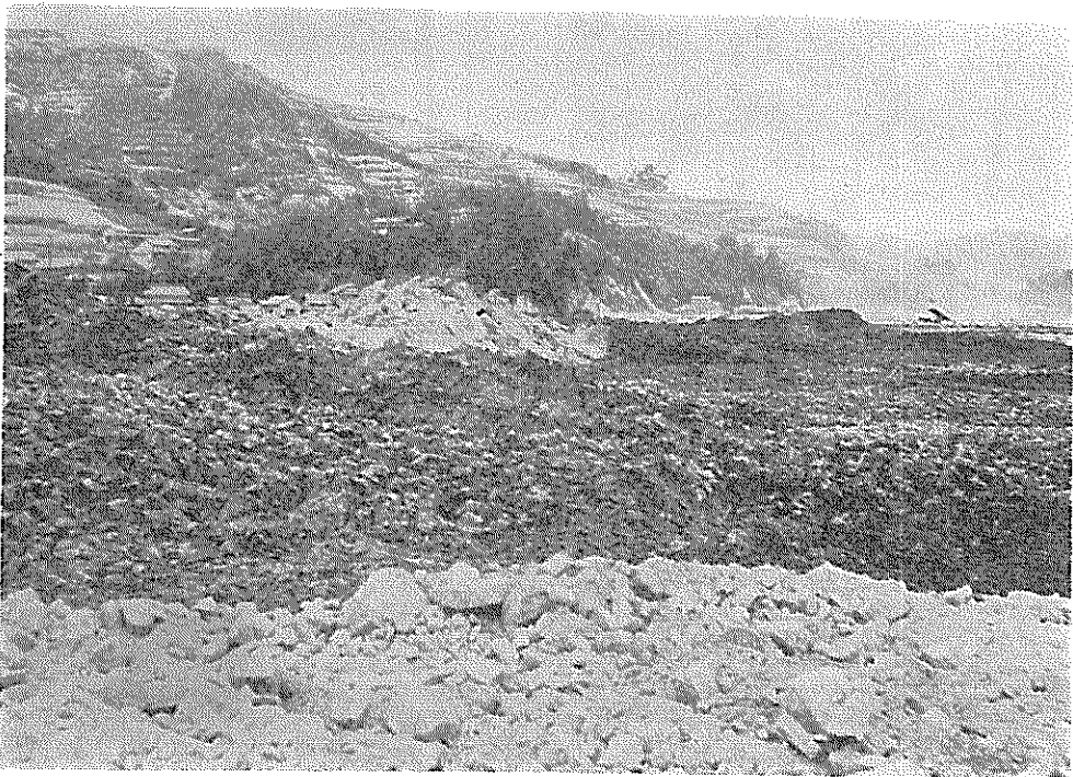
硬質土埋立による軟弱土の押出し
