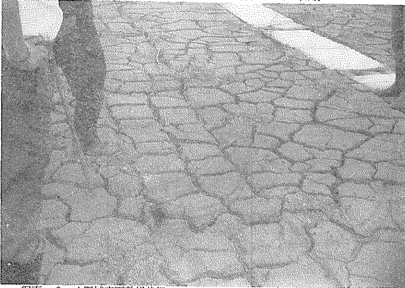
写真一六 A区域表面乾燥状況
