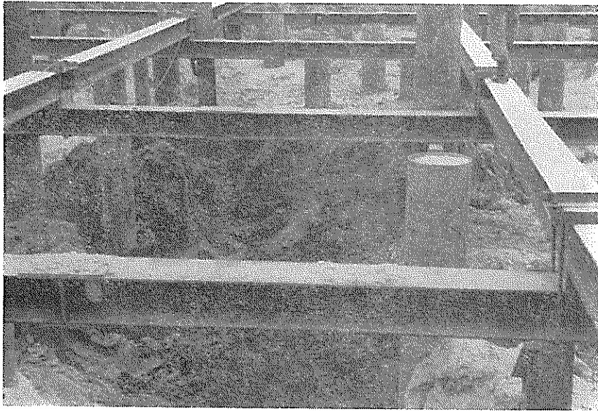
写真-2 サンドドレーン施工後の根切工事
