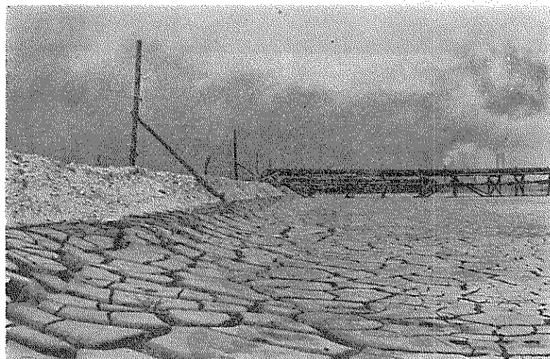
同上4ヶ月後(左は山土築堤) 軟弱粘土による埋立地
