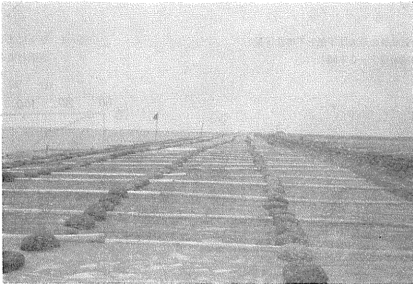
写真一—1— b 天端保護用帆布 荒天時の波浪による中埋土砂の流失を防ぐ 帆布は 5.5m×16.0m
