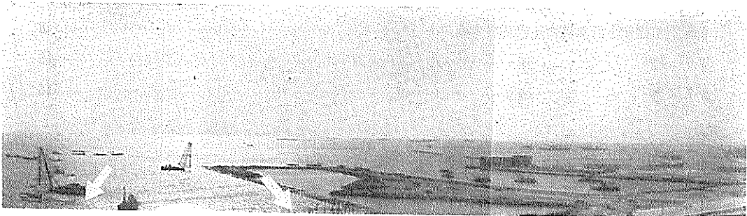
写真一 摩耶埠頭のケーソン沈設現場 矢印がケーソン沈設予定地
