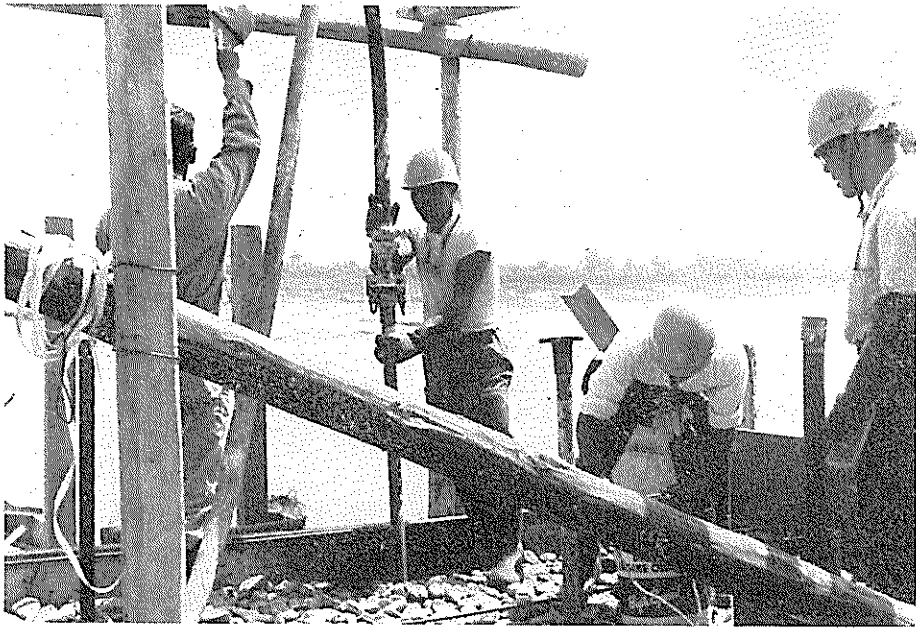
モルタルの注入
