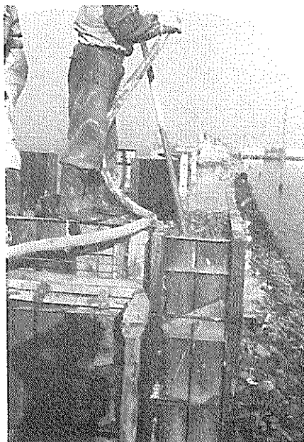
モルタル注入
