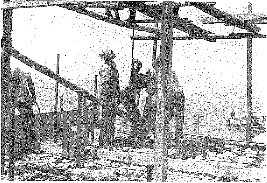
注入管の建込み
