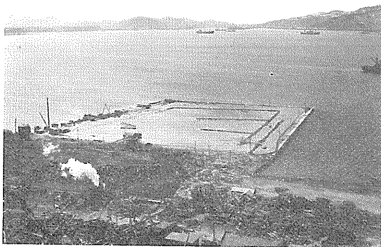
施 工 現 場 全 景
