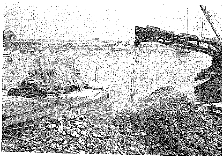
(4) 砂利の積出しと洗滌 (田後港防波堤工事)
