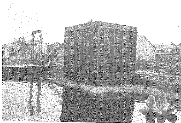
型枠組立て終了(搬出前)
