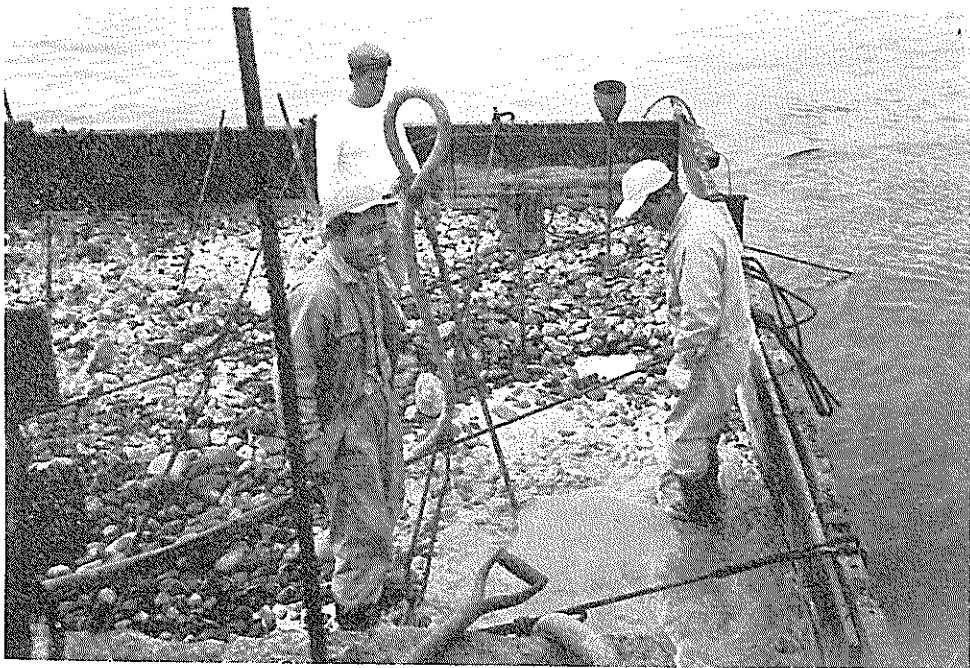
モルタル注入
