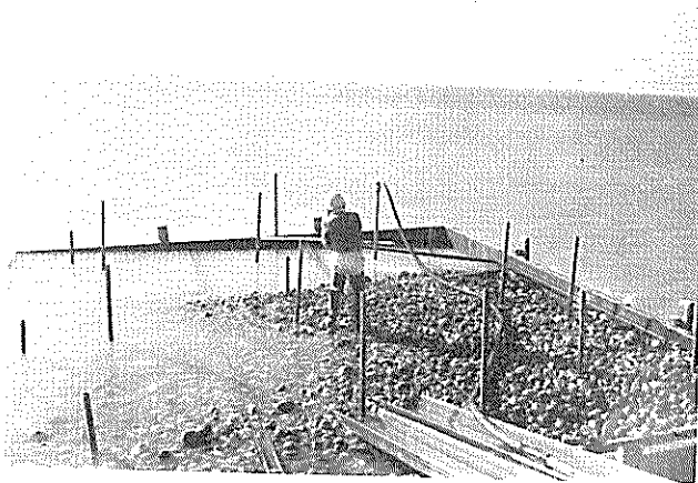
モルタル注入
