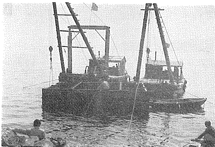
型枠の据付け(独立型枠)
