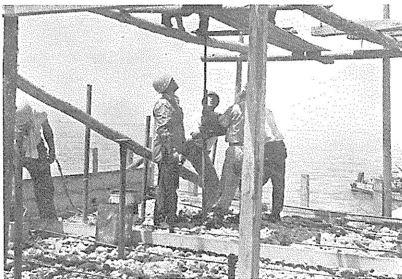
(6) 注入管の建込み (新潟港東港地区西防波堤工事)
