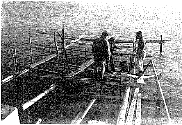
モルタル注入
