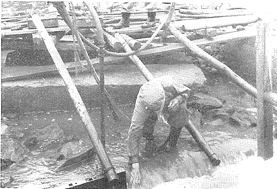
モルタル注入状況(モルタルで置換えられた水が越流中)
