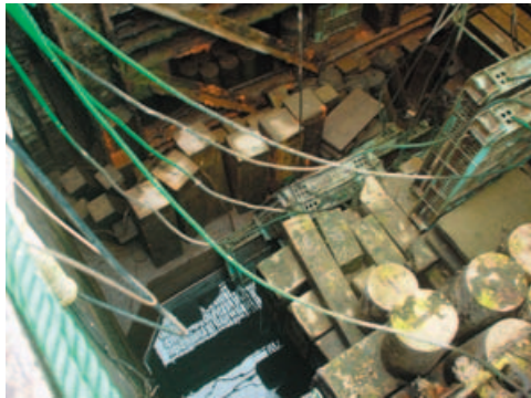
写真-1 海水循環水槽暴露状況
