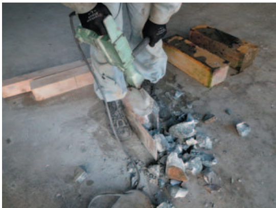
付写真-6.11 供試体解体状況
