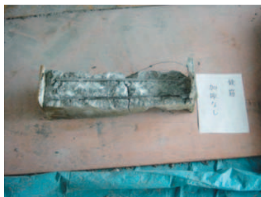
付写真-6.6 供試体からはつり出した鋼材①
