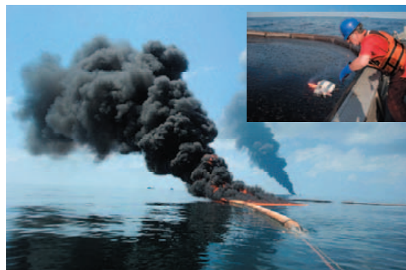
図-20 MC252 における現場焼却(右上 着火作業)
