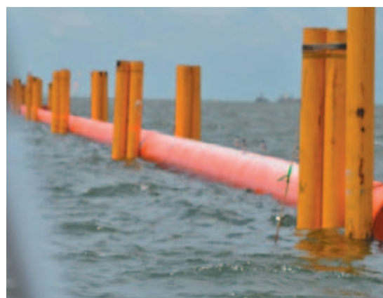
写真-4 鋼管製オイルブーム
