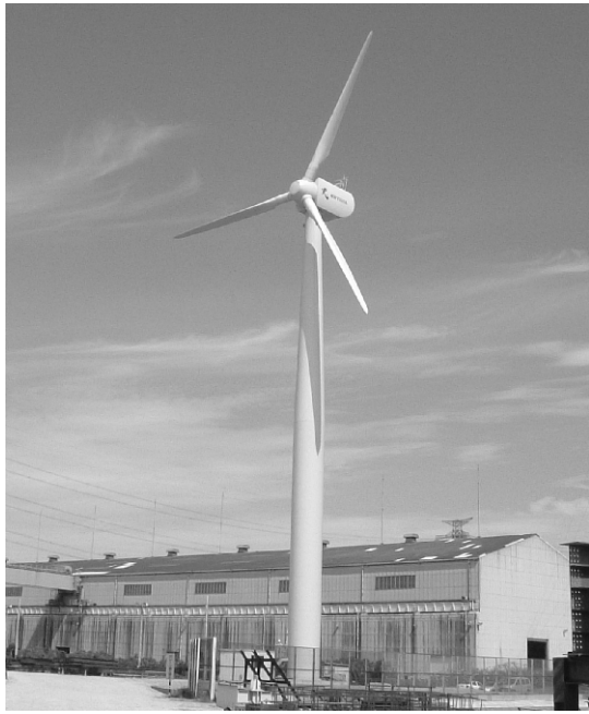
写真-2.1 実証試験の全景（駒井ハルテック富津工場）
