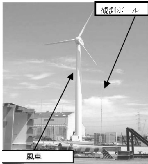
写真-2.5 風車の外観
