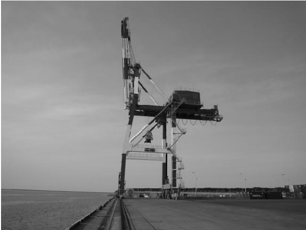
写真-5.3 ガントリークレーン
