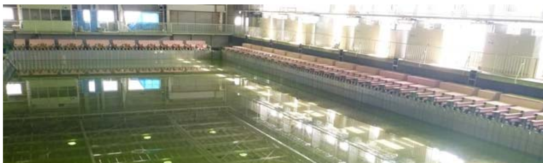
写真-4.1.1 デュアルサーペント水槽の完成写真
