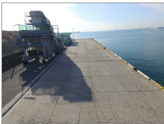
図-1.1.3.4 コンクリート舗装(高度約 9m)
