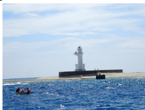
地盤状況の確認@ルカン礁
