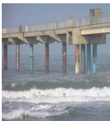
図-1.1.2.3 波崎観測栈橋での被覆防食工法の長期暴露試験
