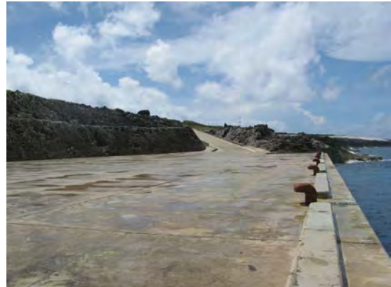
写真-1.1.1.10 岸壁とその背後地の状況（北大東島北地区：他の岸壁も似た状況）
