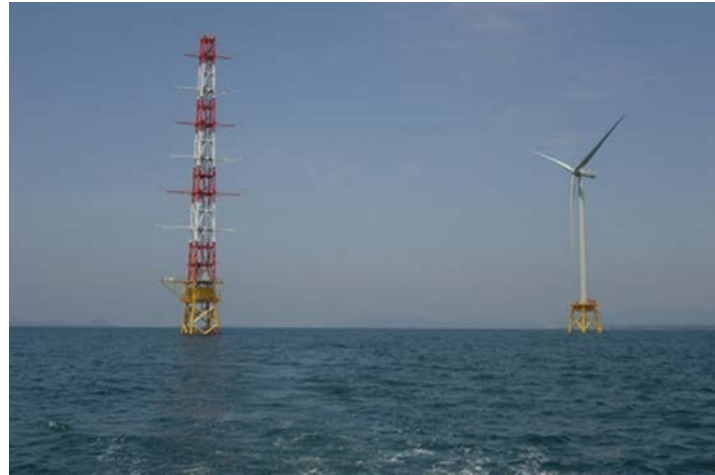
写真-1.1.1.7 北九州沖での洋上風況観測および洋上風力発電に関する現地実証試験
