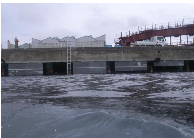
写真- 1.1.1.6 実栈橋での前垂れによる塩分浸透抑制効果の確認実験の状況
