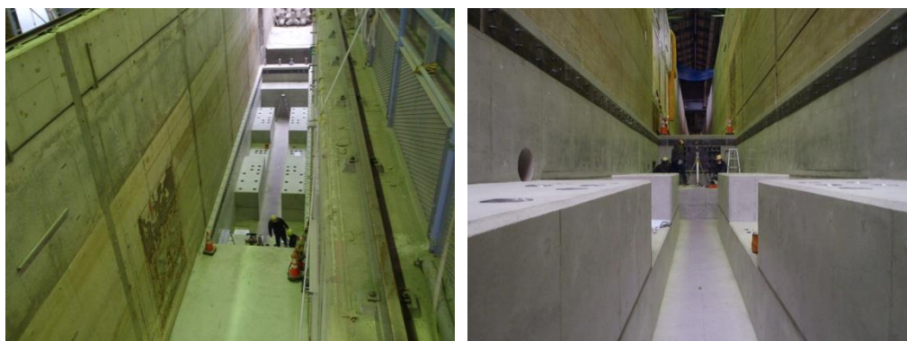
写真-4.1.1.1 振動台テーブルの基礎部の工事状況
