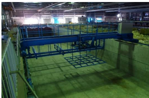
写真-4.1.1.1 計測装置(トラバース装置)
