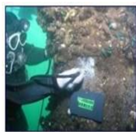
写真-1.1.1.6 超音波厚さ計による鋼の肉厚調査
