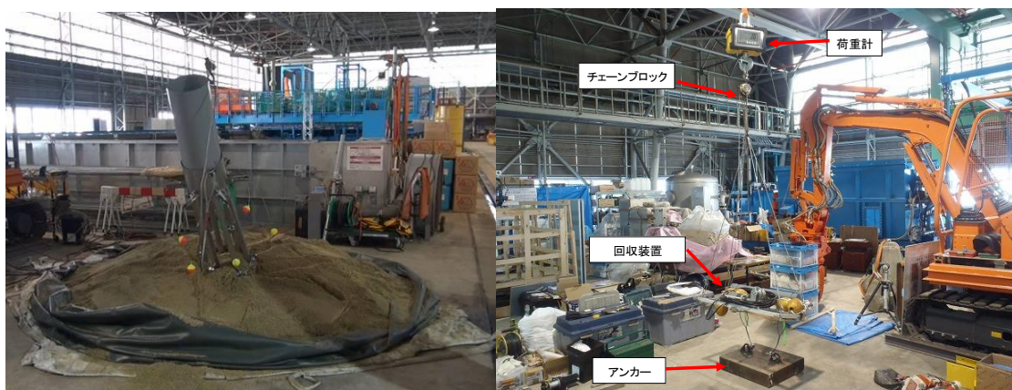
写真-1.1.1.3 移動時の動作状況確認
