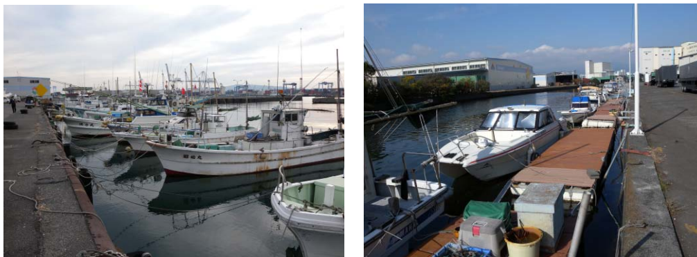
写真-2.1.1.8 係留船舶等の状況に関する現地調査
