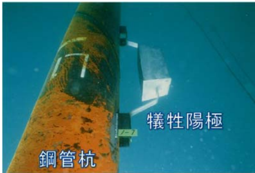
写真-2.1.3.3 海水中の陽極の取付状況
