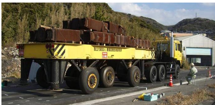
写真-2.1.4.6 舗装材料の耐久性に関する実大載荷実験
