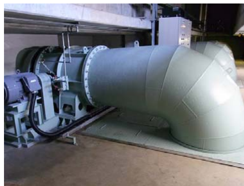
写真-4.1.1.2 水理模型実験水槽の潮流発生装置
