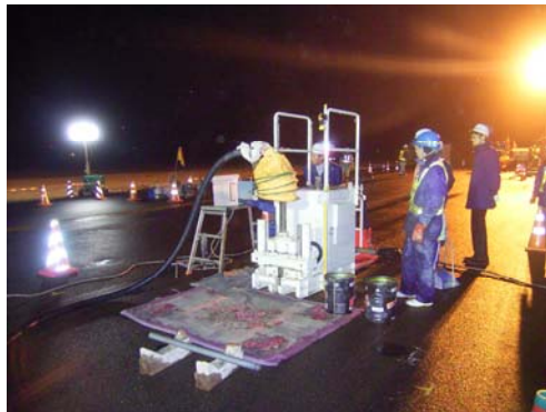
写真-2.1.1.1 新潟空港における液状化対策工事
