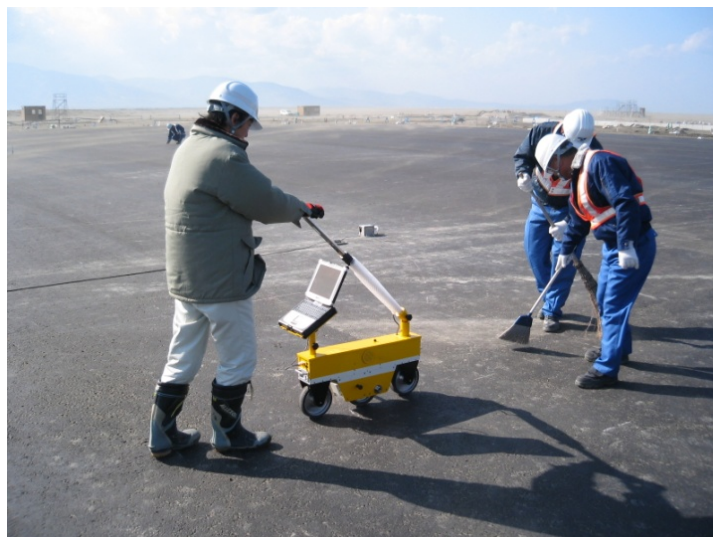
写真-2.1.4.13 応急復旧工法の一例（耐航空機荷重路面マット）
