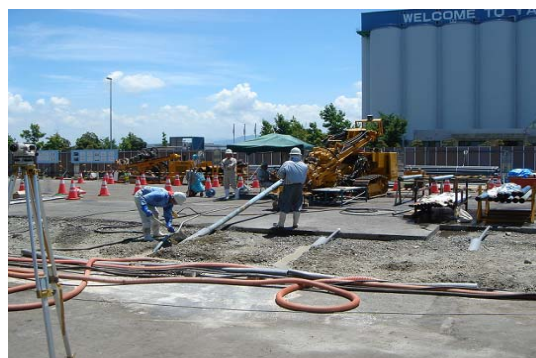
八代港での活用状況
