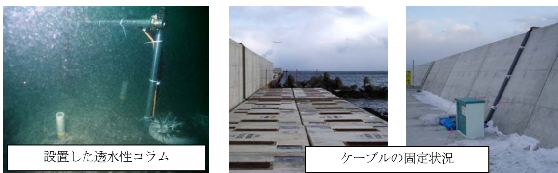
写真-2.1.4.2 白老港における試験施工状況
