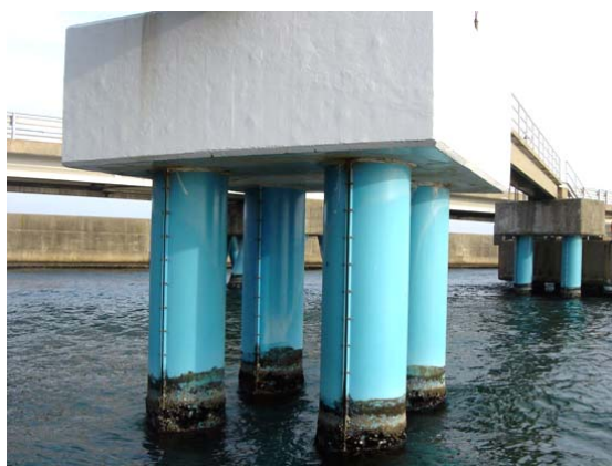
写真-2.1.3.7 ペトラタム被覆工法による鋼構造物の防食
