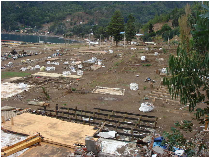
写真-2.1.1.2 チリにおける津波の被害調査
