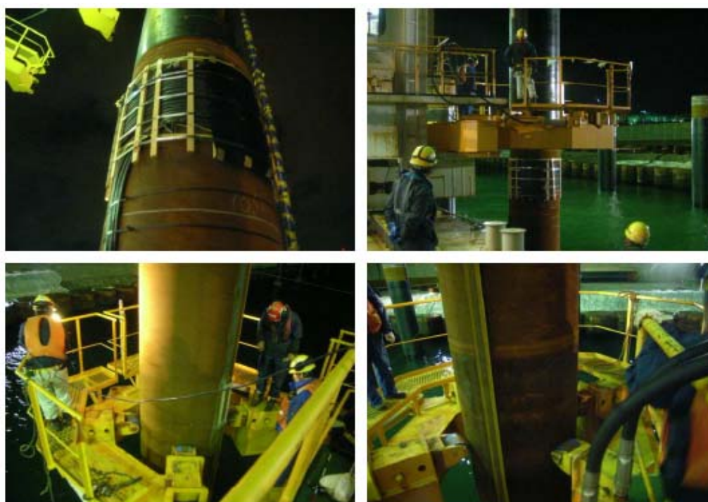
写真-2.1.2.2 電流量モニタリング装置を設置した鋼管杭の打設状況
