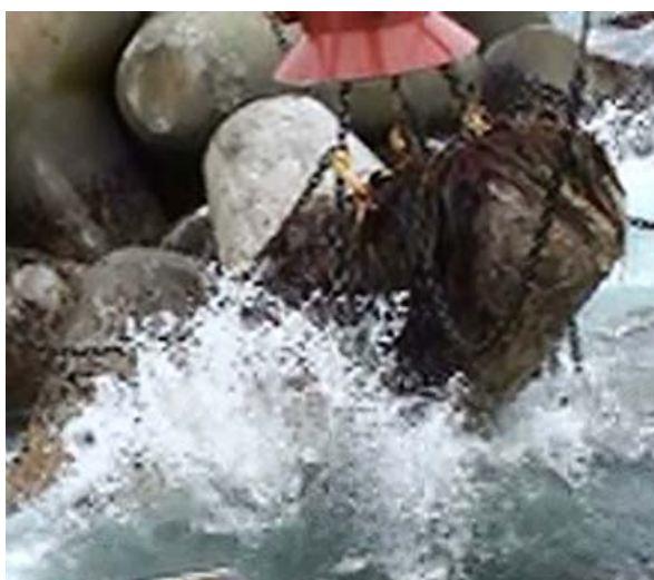
写真-2.1.1.9 荒天時のブロックの回収 (平成 21 年 8 月 5 日、久慈港)
