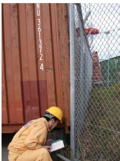
写真-2.2.8.3 コンテナの流出状況調査（平成 21 年 10 月 9 日）
