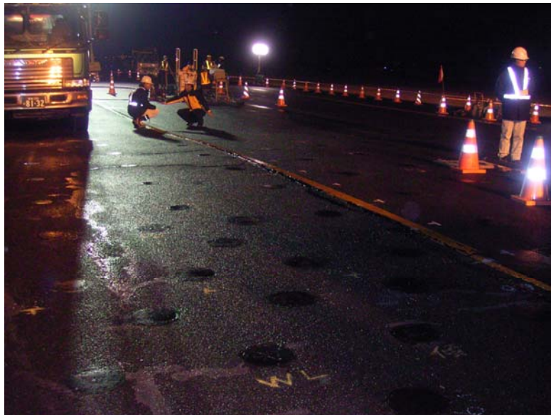
写真-2.1.1.1 仙台空港における締固系液状化対策の施工状況
