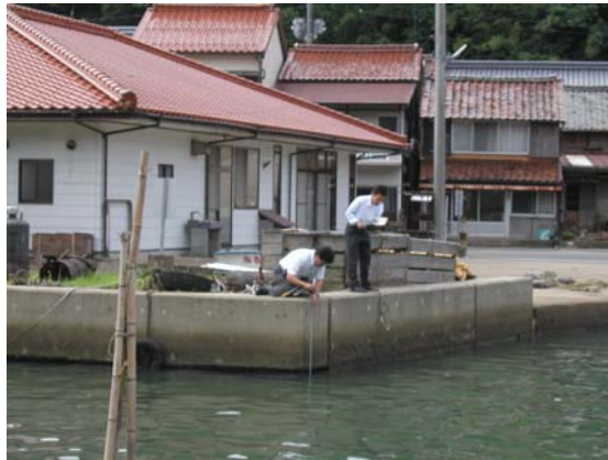
写真-2.2.8.4 江崎港（山口県）での調査（平成 21 年 7 月 27 日～28 日）
