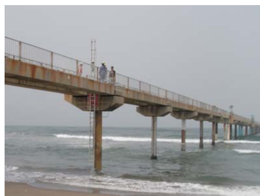
栈橋上の計測状況
