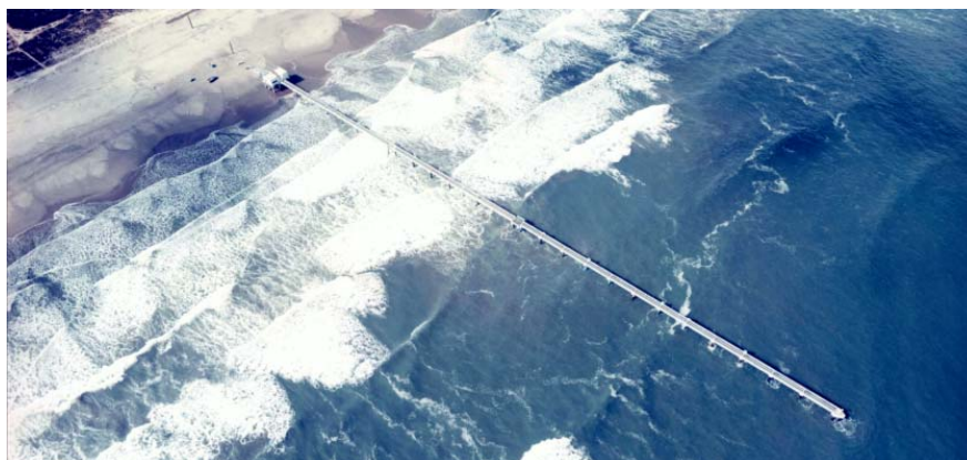
写真-2.1.2.4 波崎海洋研究施設（HORS：茨城県神栖市）
