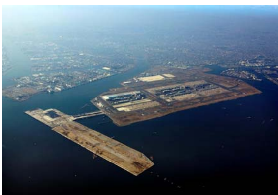
建設状況(平成22年2月現在)
