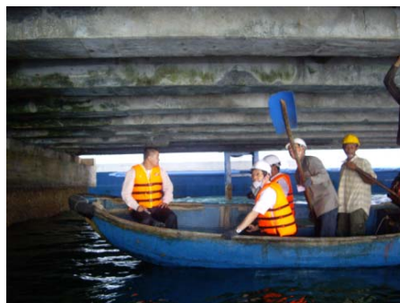
現場実習の様子
