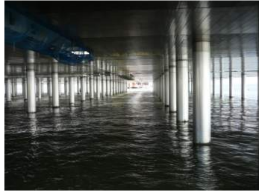
栈橋部上部のステンレス被覆防食工法
