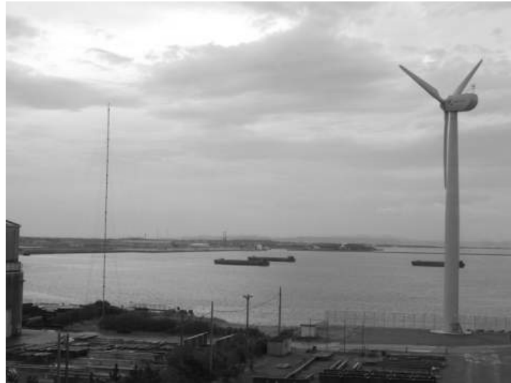
写真-2.1.30 東京湾沿岸富津サイトにおける中型風力発電実証試験 (左のポールは、周辺風況観測のための測風施設である)
