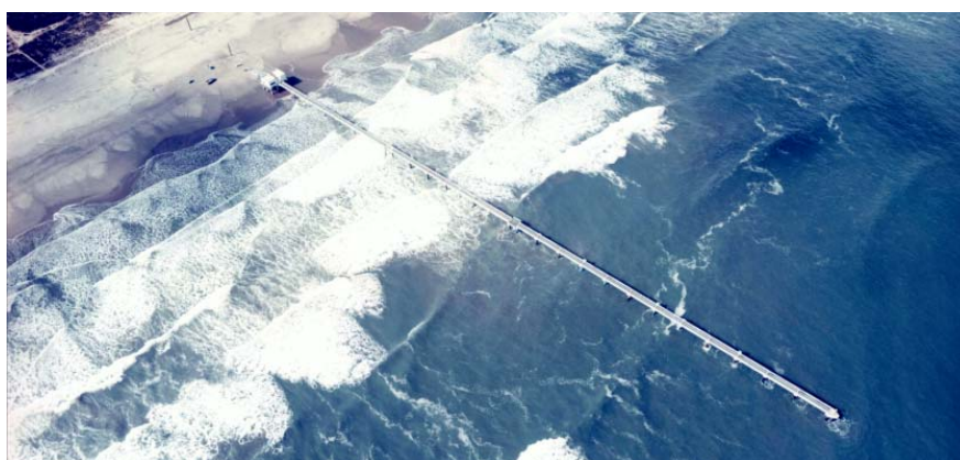
写真-2.1.14 波崎海洋研究施設 (HORS : 茨城県神栖市)
