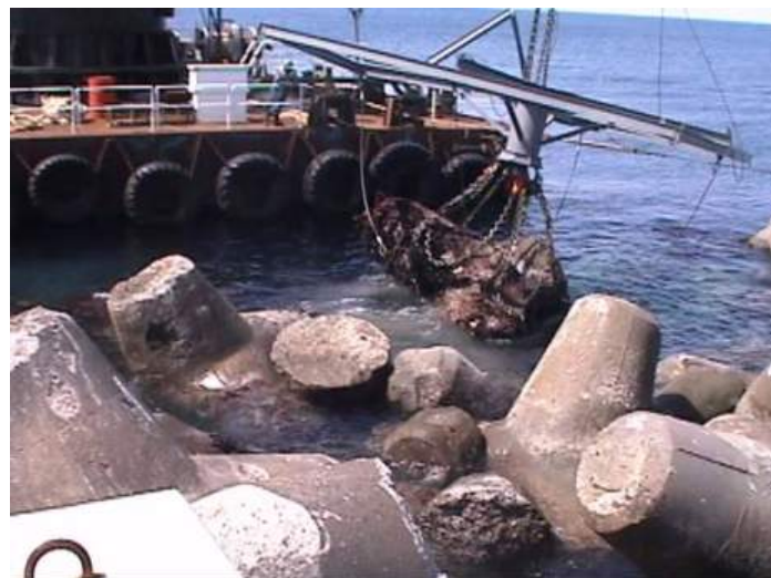
写真-2.1.6 消波ブロックの回収（留萌港）
