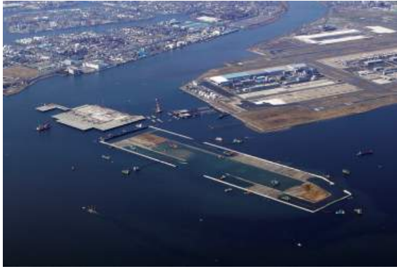
建設状況(平成 21 年 3 月現在)
