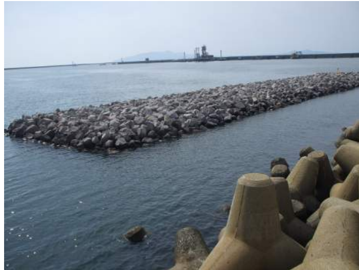
写真－1.2.4 秋田港内での長周期波対策砂礫層の整備
