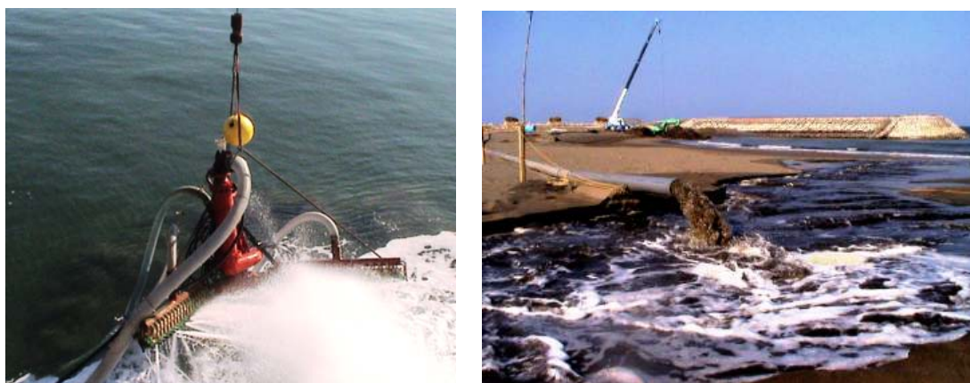
写真-2. 1. 3 宮崎港における実証実験（左：有孔管簡易浚渫装置 右：排砂状況）
