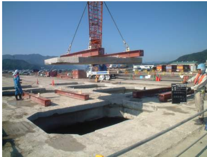
写真-2.1.8 棧橋上部工からの詳細分析用試験体切り出し状況
