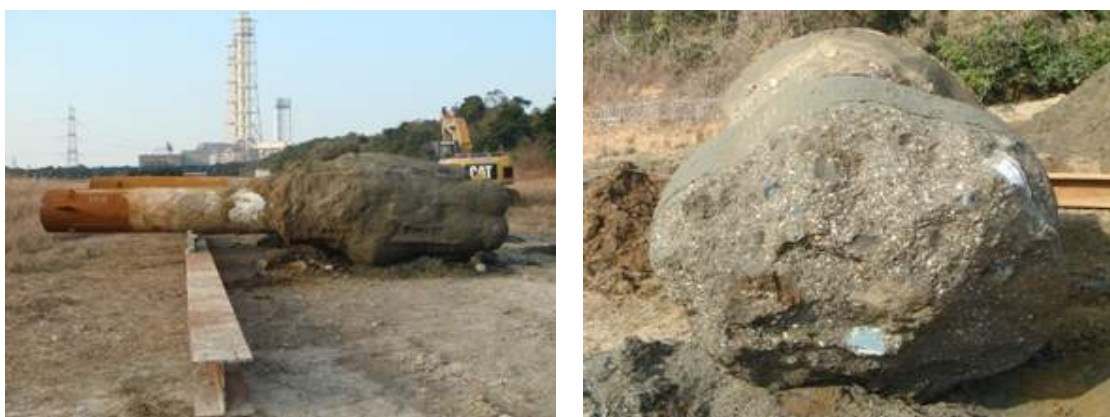
写真-2. 1. 28 RS プラス工法によって築造した根固め部の状況
