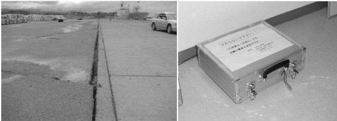
写真-2. 2. 28 柏崎港中浜埠頭の被災状況写真と余震観測用小型地震計
