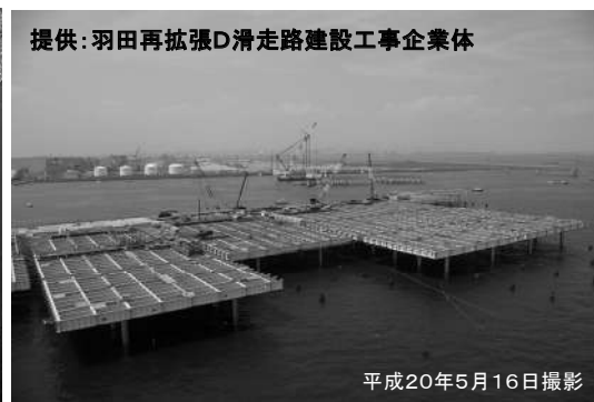
D滑走路の工事状況
