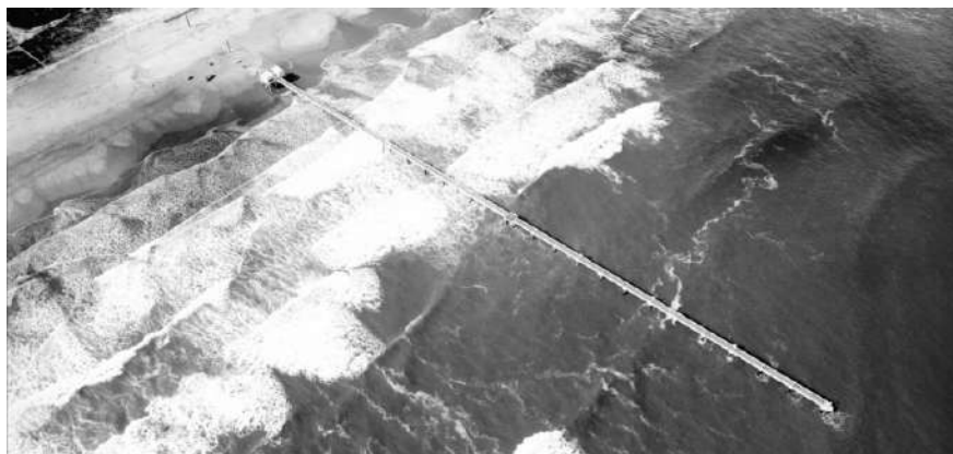
写真－2.1.13 波崎海洋研究施設（HORS：茨城県神栖市）
