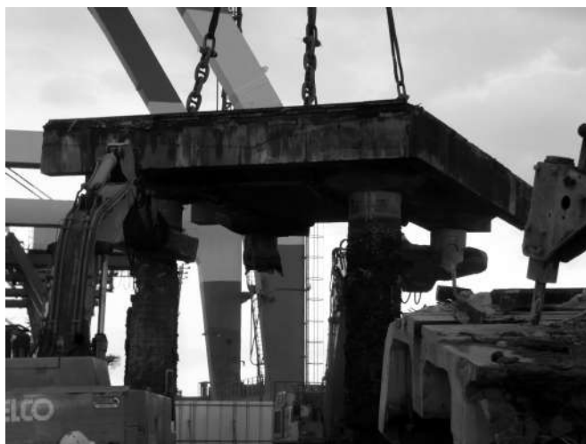
写真－2.1.6 内部鉄筋の劣化メカニズム解明のための実構造物からの試験体採取状況
