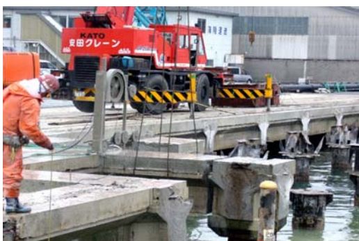
実構造物からの試験体採取
