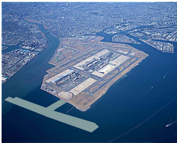
写真-2.1.8 羽田空港再拡張プロジェクト
