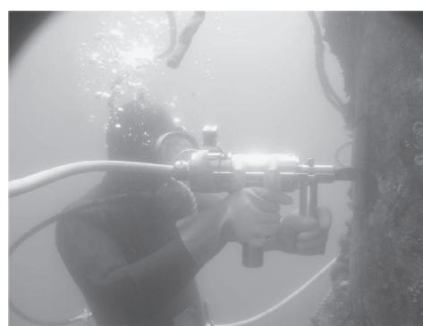
超音波溶着法によるポリエチレンライニングの補修
