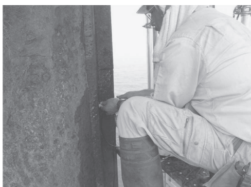
鋼管杭の肉厚測定
