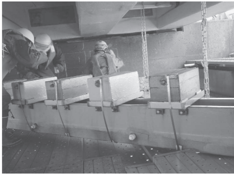
補修実績調査の状況
