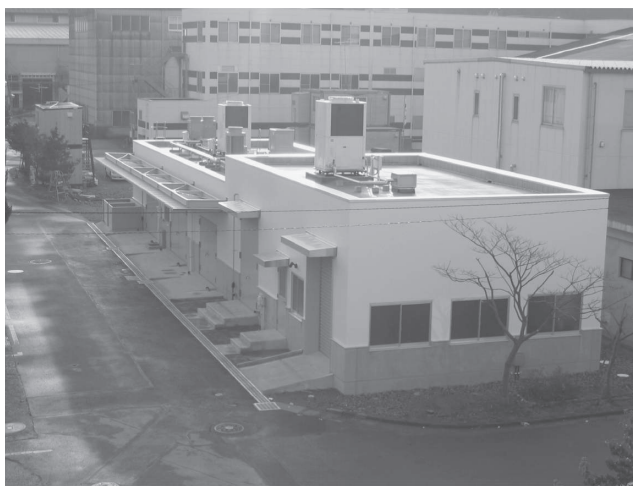
写真-7.1.4 コンクリート試験体の製造及び養生施設
