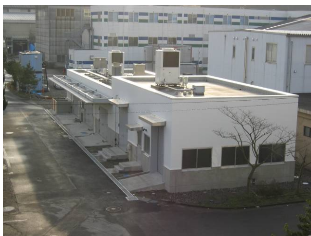
写真-7.1.4 コンクリート試験体の製造及び養生施設
