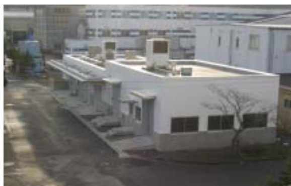
写真 - 7. 1. 3 コンクリート試験体の製造及び養生施設
