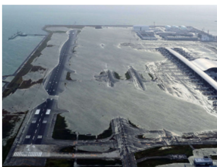
平成30年台風21号: 滑走路が浸水した関西国際空港 (引用: 毎日新聞)
