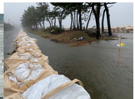
令和元年台風19号: 福浦地区の浸水状況(引用: 横浜市 港湾局)
