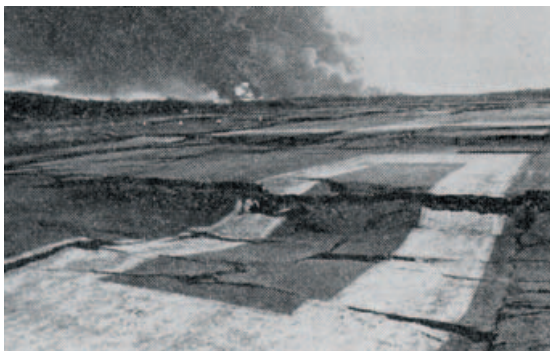
写真-1 新潟空港における滑走路の被災状況
