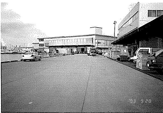
写真-29 釧路港東港区の奥部にある物揚場
