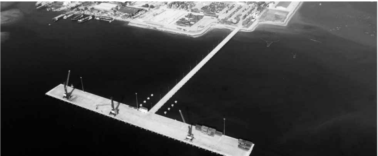
サバ港サパンガール・ベイ・コンテナターミナル・プロジェクト
