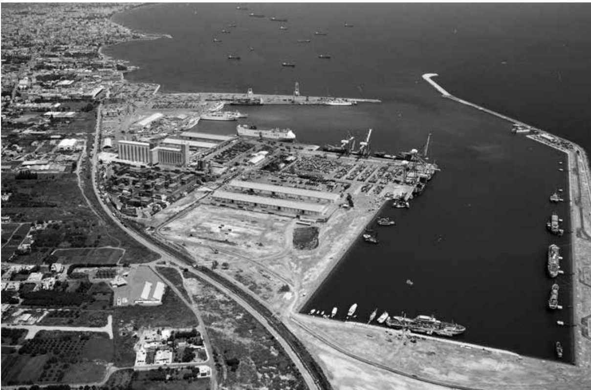
リマソール港（航空写真）
