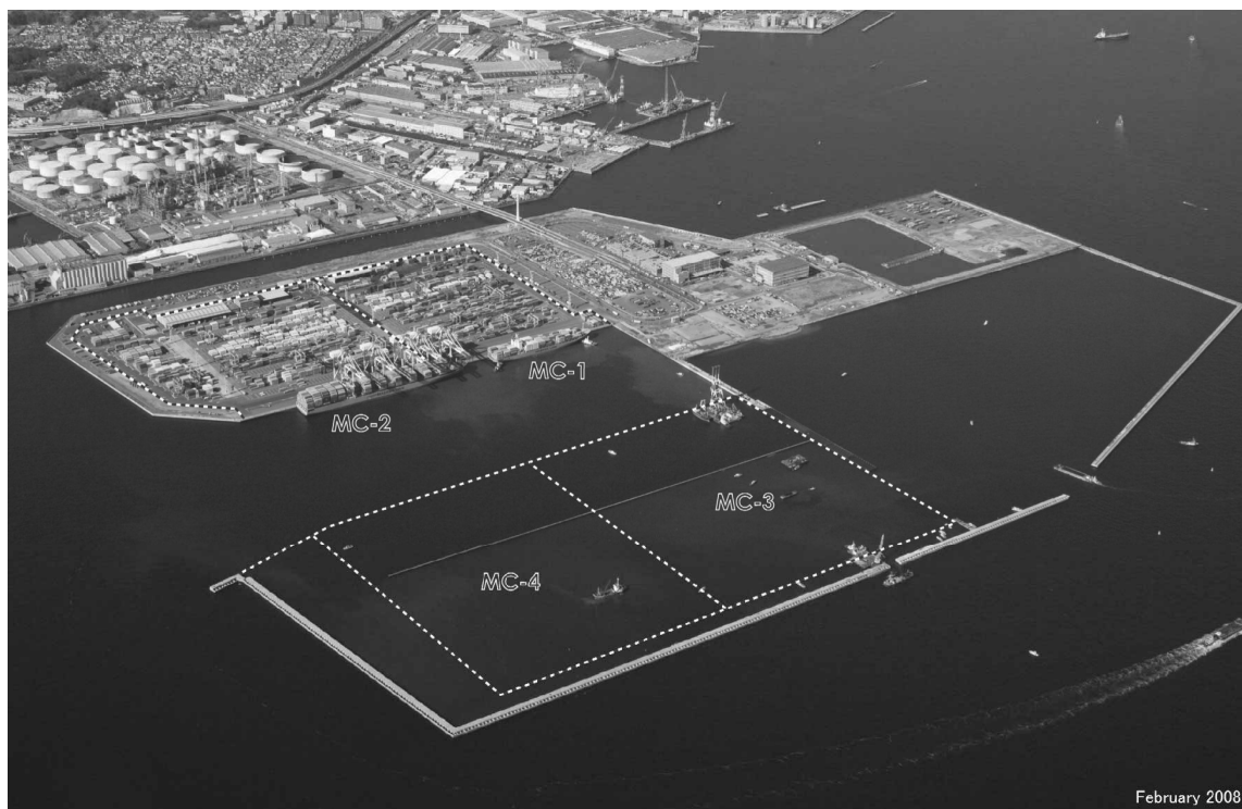
横浜港・南本牧埠頭コンテナターミナル・プロジェクト (MC-3/4)
