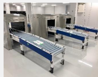
出荷検品用ゲート (共同院外倉庫)
