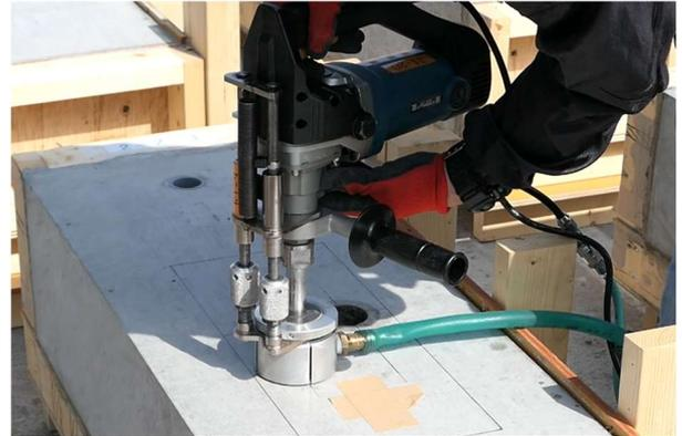
図-1 円柱状シアキー施工機器の例
