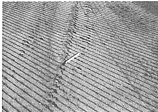
写真-2 グルーピングの角欠けの代表例
