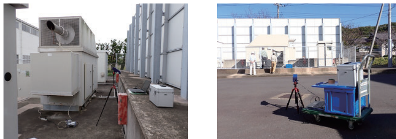
図—3.2 非常用発電機におけるハイパースペクトルイメージの取得風景。
