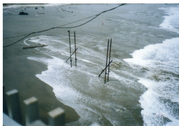
写-2 波の遡上と流下による砂浜海岸の侵食
