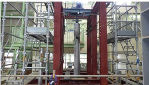
写真-4 杭 L の貫入時の様子
