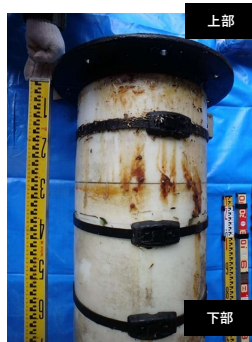
図-22 上端部からの油分の漏洩状況（南面）
