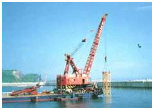
図-2.3 重錘均しの状況 (文献 3) より引用)
