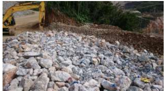
図-4.17 作業後のマウンドの天端の状況
