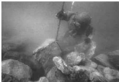
図-2.1 マウンド荒均し作業（±300mm）
