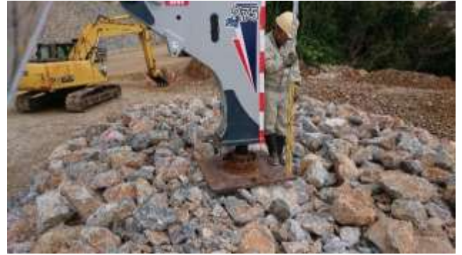
図-4.7 沈下量計測実験の計測の様子
