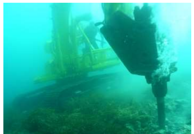
図-3.8 水中バックホウに装着された油圧ブレーカ （あおみ建設株式会社 HP より画像を引用） （引用元： https://www.aomi.co.jp/tech/civil/biggrab.html ）
