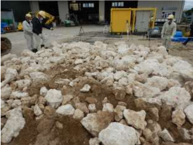
図-6.19 一回目均し後 マウンド写真
