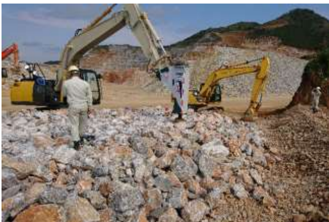
図-4.15 作業時間計測実験実施の状況
