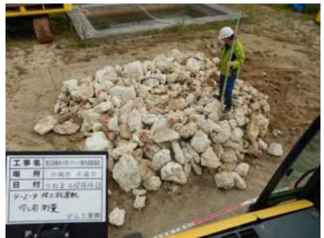
図-6.17 一回目均し前 マウンド写真
