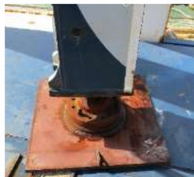
図-4.13 溶接後の転圧板
