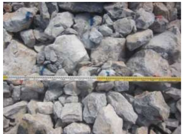
図-4.19 作業後の捨て石の状況
