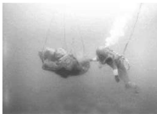
図-2.2 マウンド石材の移設
