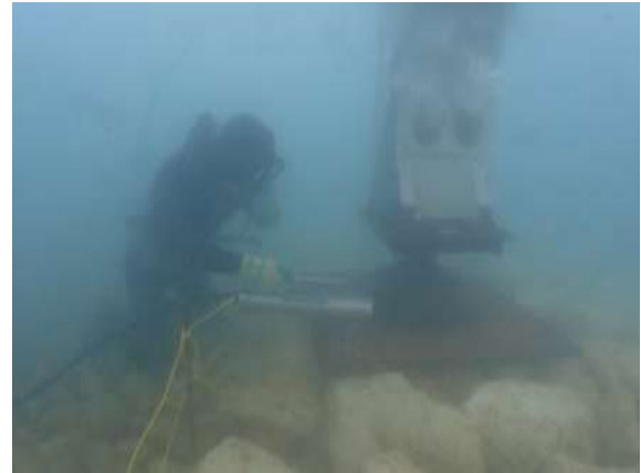
図-5.3 水中水準器によるマウンド高さの計測
