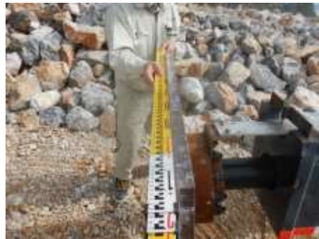
図-4.11 転圧板に生じた反りの様子
