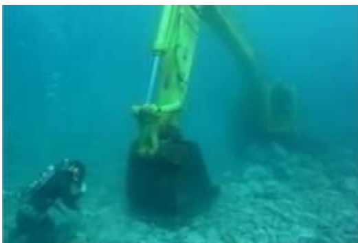
図-2.5 水中バックホウによるマウンド均しの状況
