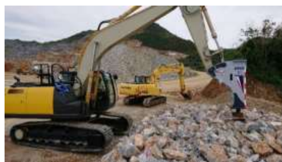
図-4.6 沈み込み量計測実験の状況
