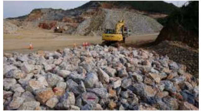
図-4.16 作業前のマウンドの天端の状況
