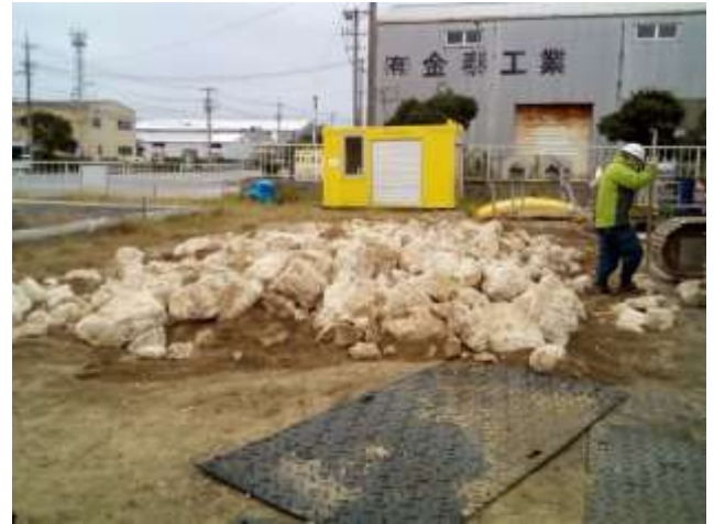
図-6.25 二回目均し後 マウンド写真
