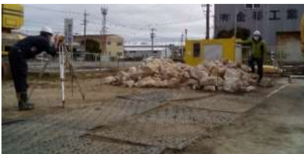
図-6.16 均し前形状計測の様子
