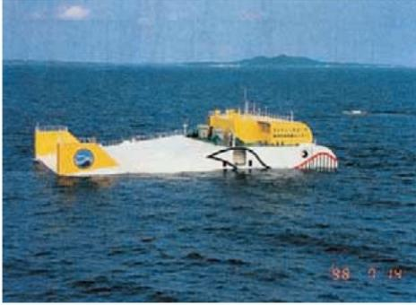
図-3.1 浮体式波力発電装置（振動水柱型）
