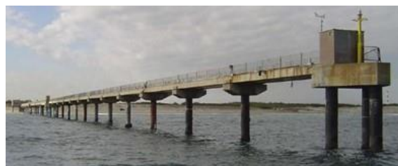
写-3.1 波崎海洋研究施設 観測栈橋 沖から撮影
