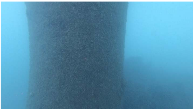
写真-4.23 鋼管杭(ドルフィン 水深 5.6m 付近)
