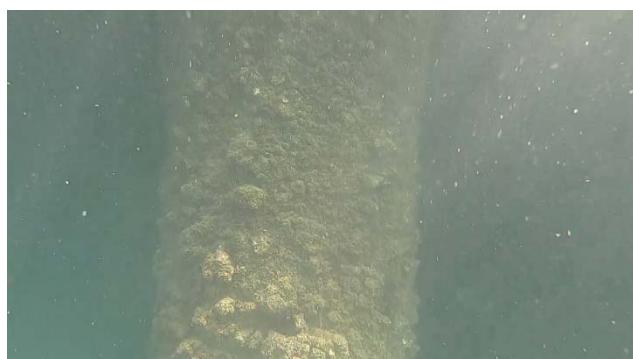
写真-4.8 鋼管杭(棧橋 水深1.5m付近)
