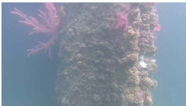
参考7 濁り発生時の鋼管杭の画像
