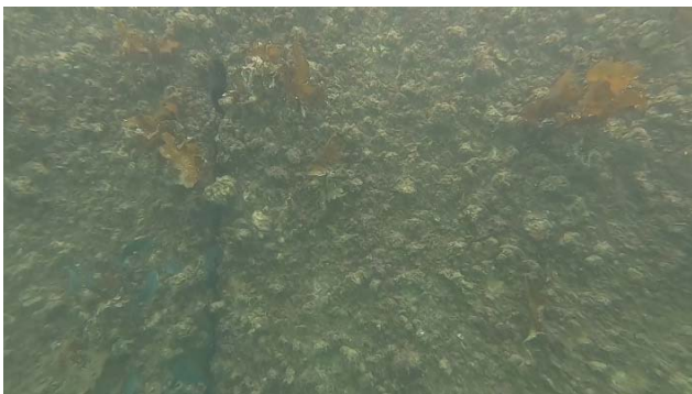
写真-4.16 ケーソン(水深 2.0m 付近)
