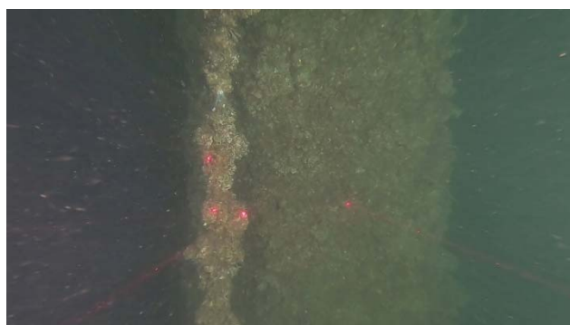
写真-4.12 鋼管杭(棧橋 水深3.0m付近)
