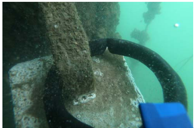
写真-5.9 発生電流量の測定状況(鋼管杭陽極上側)
