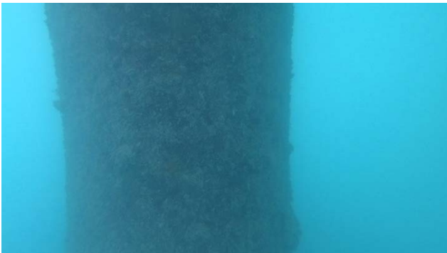
写真-4.22 鋼管杭(ドルフィン 水深 2.6m 付近)
