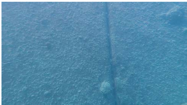
写真-4.3 ケーソン側壁の撮影画像(水深 4.0m 付近)
