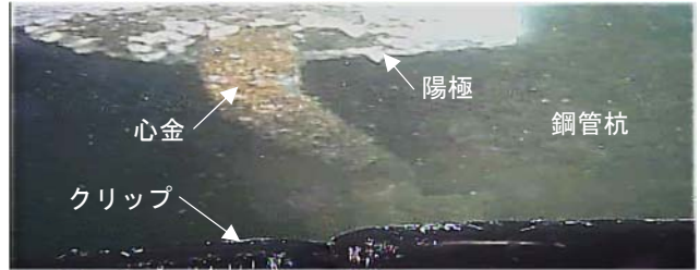
写真-5.7 陽極下側(鋼管杭)の設置状態 (位置確認用カメラ)
