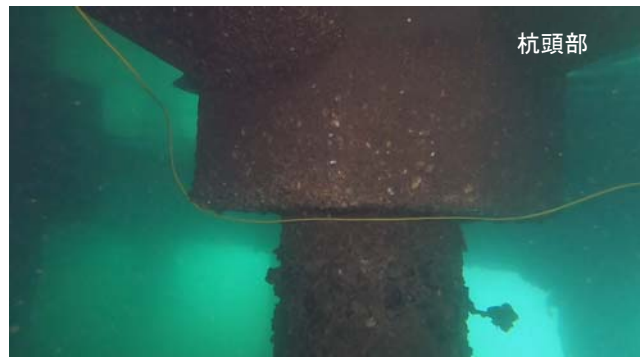
写真-4.6 テザーケーブルの引っ掛かり状況
