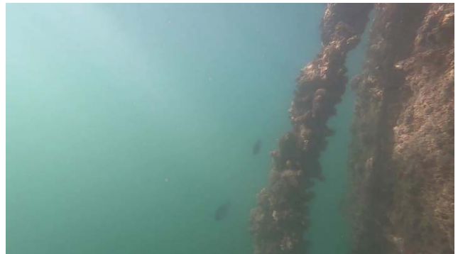
写真-4.18 係留索(水深 1.0m 付近)
