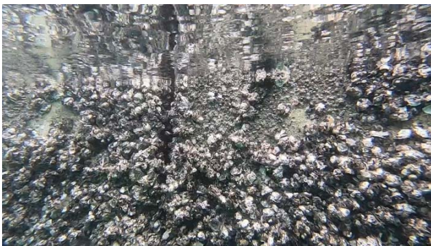
写真-4.15 ケーソン(水深 0.5m 付近)
