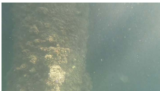
写真-4.9 鋼管杭(棧橋 水深2.5m付近)
