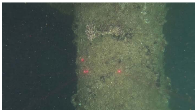
写真-4.11 鋼管杭(棧橋 水深1.2m付近)
