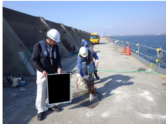
図-5.2.3 コンクリート削孔状況
