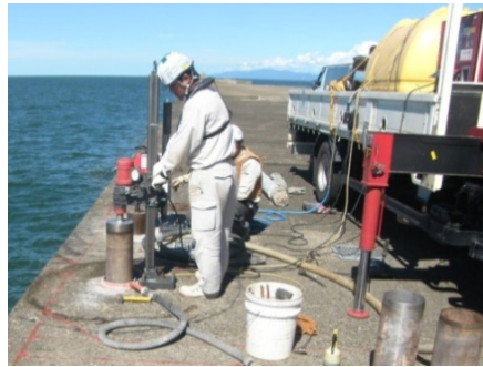
上部工削孔
