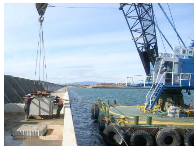
切断した上部ブロックの復旧
