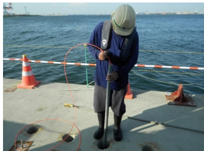
ワイヤー引込み線の挿入
