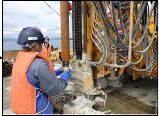
削孔内管引き抜き
