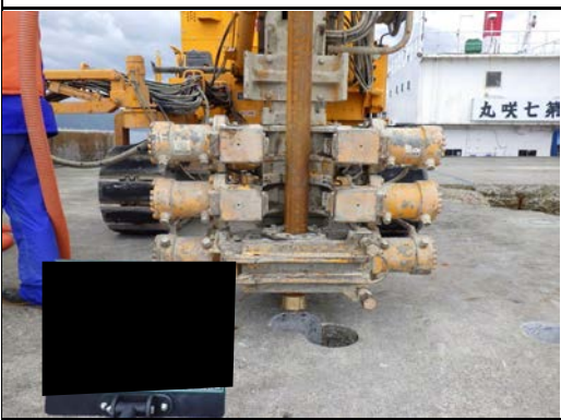
削孔ポイント設置
