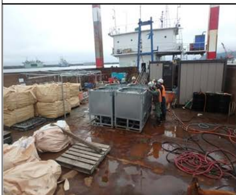
注入プラント仮設
