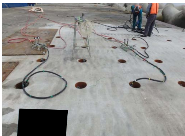
図-5.4.12 内管挿入および一次注入（CB注入）
