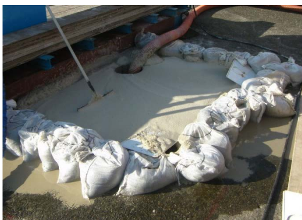
図-5.3.4 ホースを挿入して直接排泥した事例
