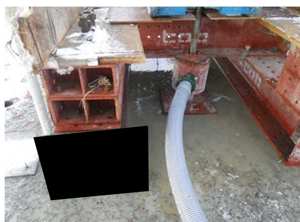
図-5.3.5 治具を用いて排泥を吸引した事例
