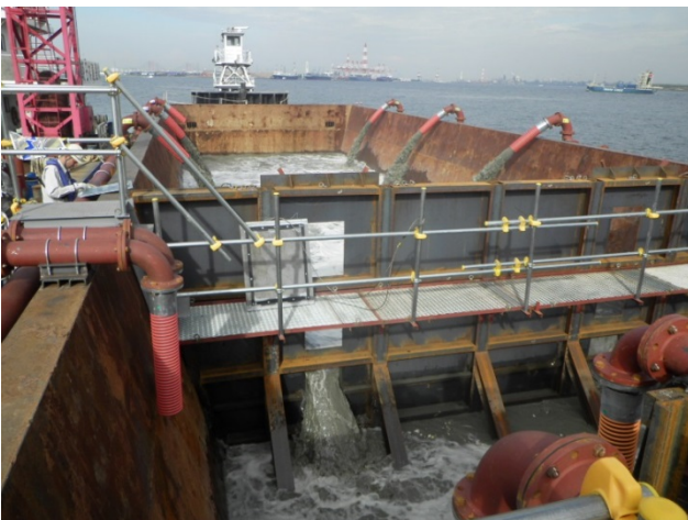
図-5.5.8 中詰砂と海水の分離状況
