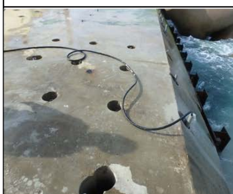
注入外管洗浄
