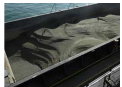
撤去後の中詰材 (水切り後)
