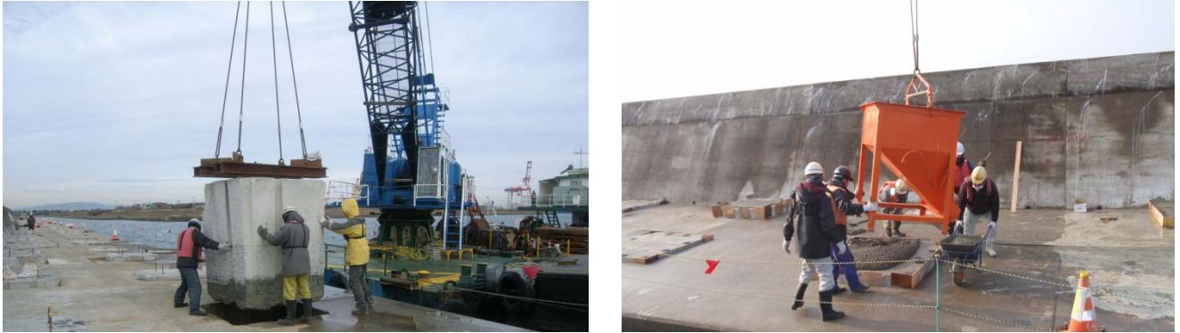
図-5.5.11 開口部復旧状況
