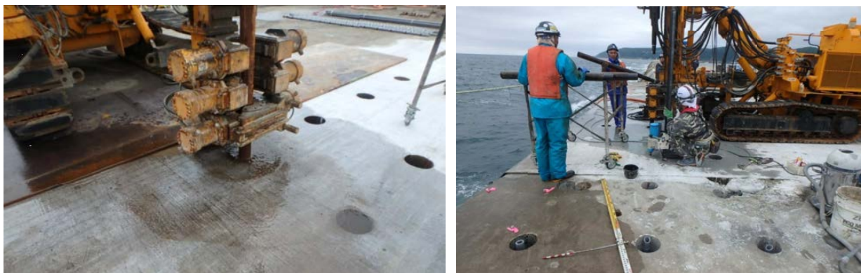
図-5.4.10 シールグラウト材注入およびケーシング引抜き
