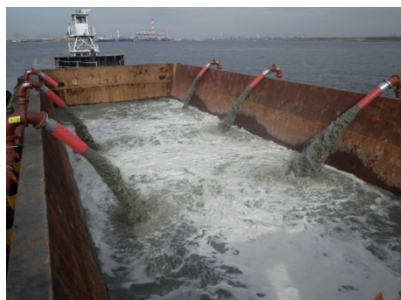
土運船へ撤去中の中詰材
