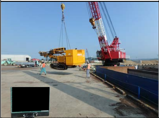
削孔プラント撤去
