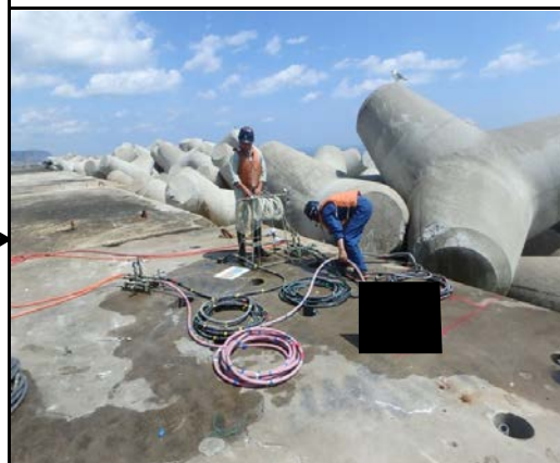
水押し試験(補足注入)
