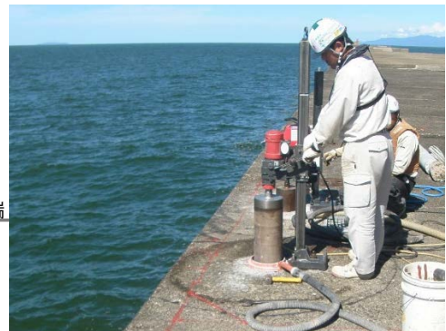
図-5.3.8 上部工削孔状況
