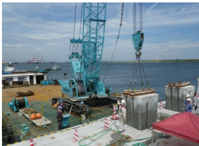
切断した上部工の撤去
