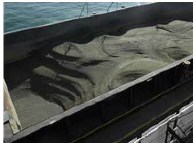
図-5.5.8 中詰砂と海水の分離状況
