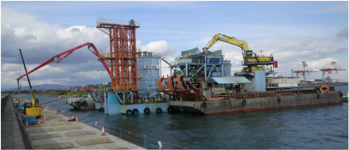
プレミックス船による中詰材とセメントの混合および打設
