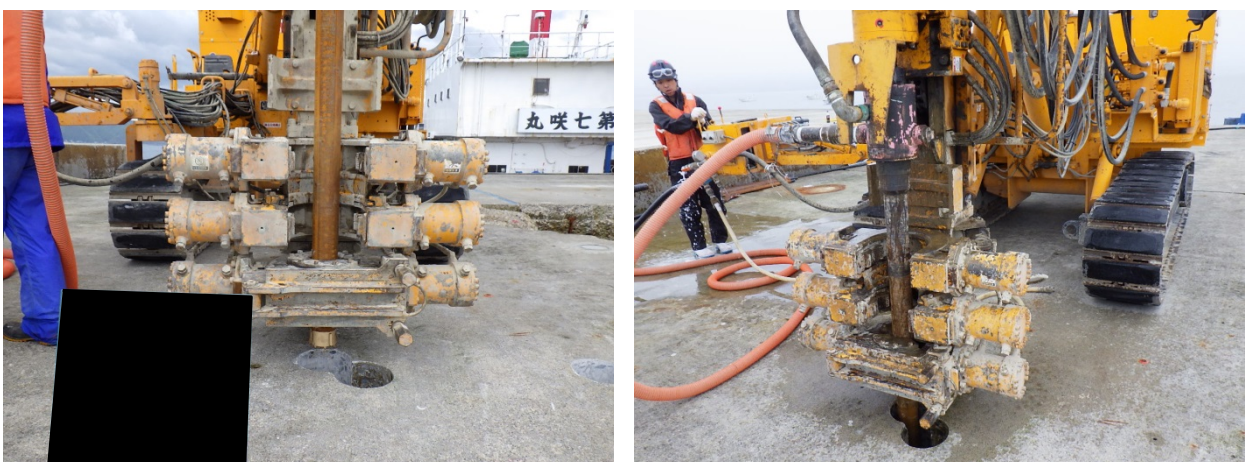
図-5.4.8 パーカッションドリル設置および削孔
