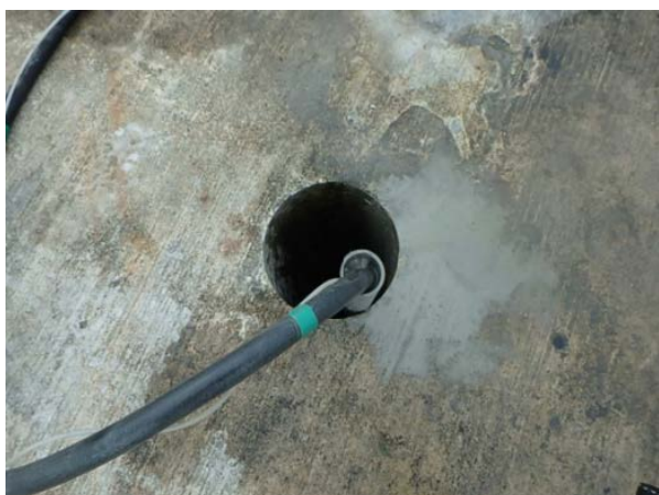
図-5.4.12 内管挿入および一次注入（CB注入）
