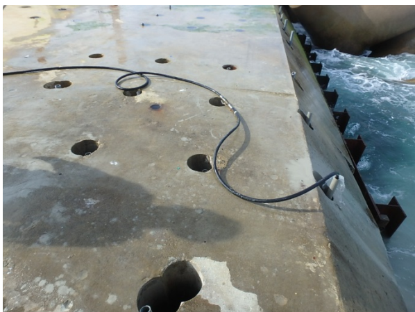
図-5.4.13 外管洗浄および二次注入（溶液注入）
