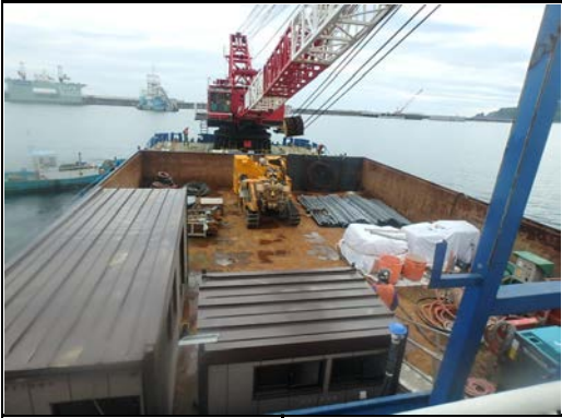
削孔プラント仮設
