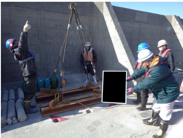
図-5.2.12 切断ブロック撤去状況
