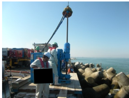
中詰材削孔
