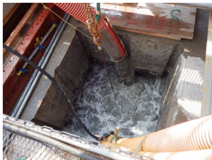
図-5.2.14 中詰材撤去状況
