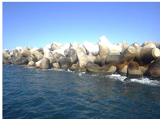
消波ブロック再据付完了
