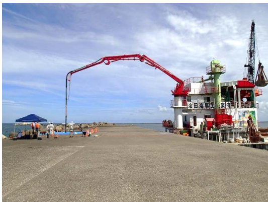
中詰コンクリート打設
