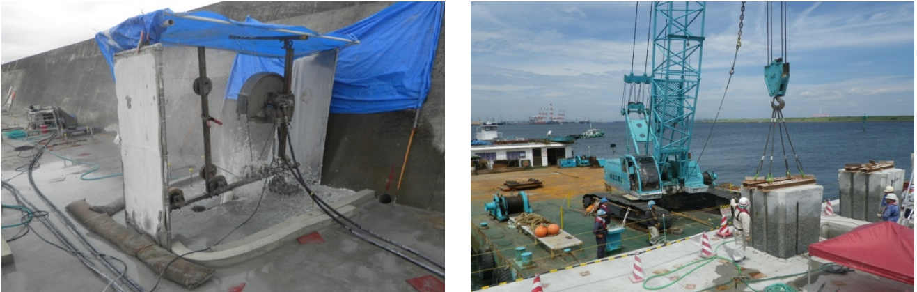
図-5.5.5 上部工切断，撤去状況
