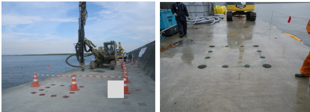
図-5.5.3 開口部設置状況
