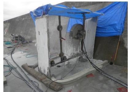
ワイヤーソーによる上部工の切断
