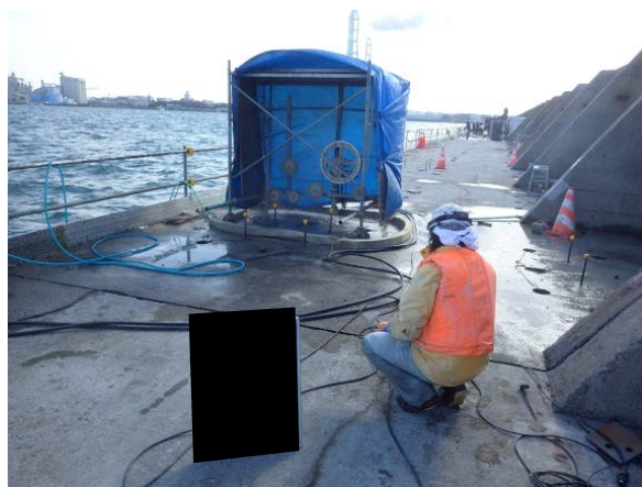
図-5.2.8 ワイヤソーイング切断状況
