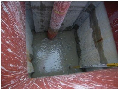
中詰材の打設
