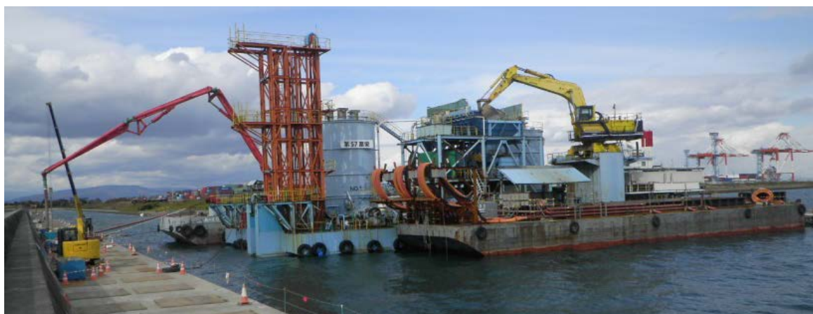
図-5.5.9 改質中詰材の打設状況（プレミックス船）
