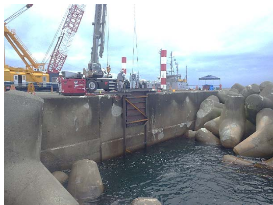
鋼製型枠設置
