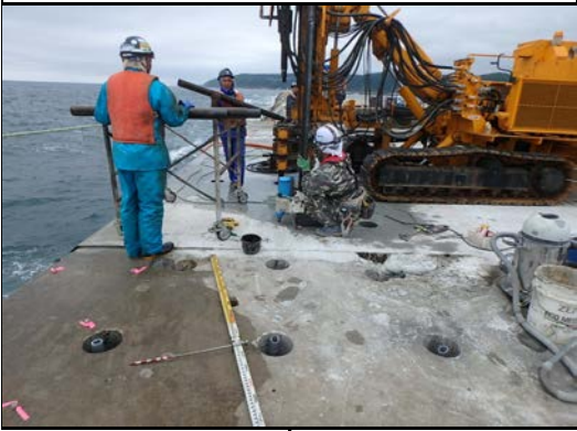
削孔外管引き抜き
