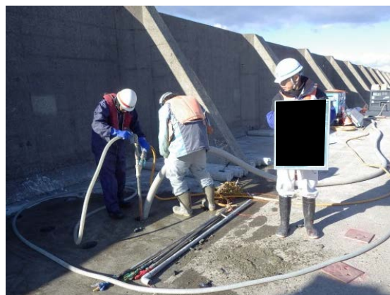
図-5.2.5 中詰材吸引状況
