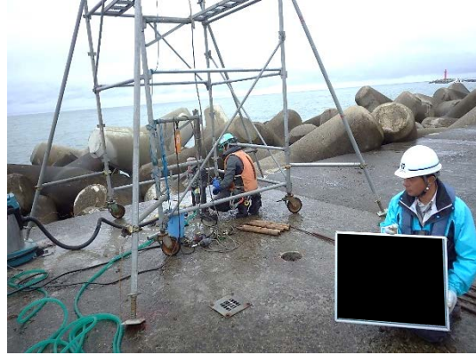
上部コンクリート削孔
