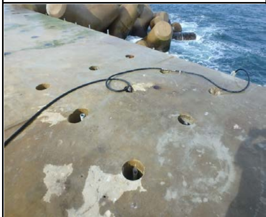
注入外管洗浄
