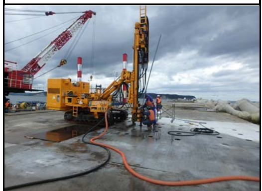
スリーブパイプ挿入
