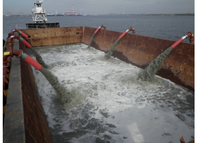
図-5.5.7 中詰材の撤去状況
