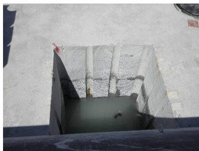
上部工の開口部
