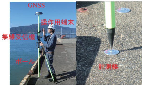
写真-2 計測点の機器構成
