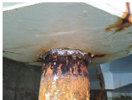
b)松山港（由良港）栈橋
