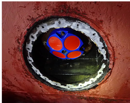
図 B-7 伊勢湾フェリーの船底に設置された ADCP
