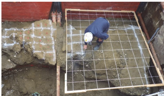
写真-3.2 調査・試験位置出し状況
