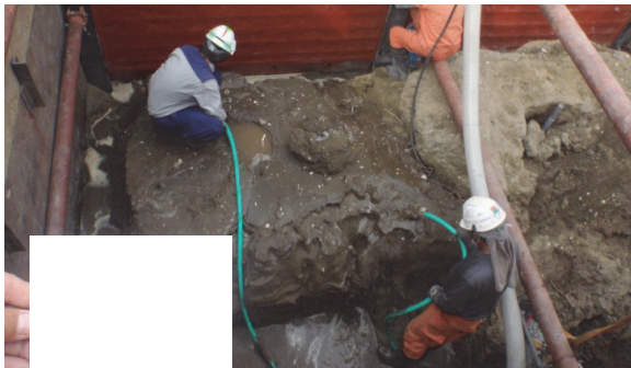
写真-3.1 人力による改良体の掘削・洗い出し状況
