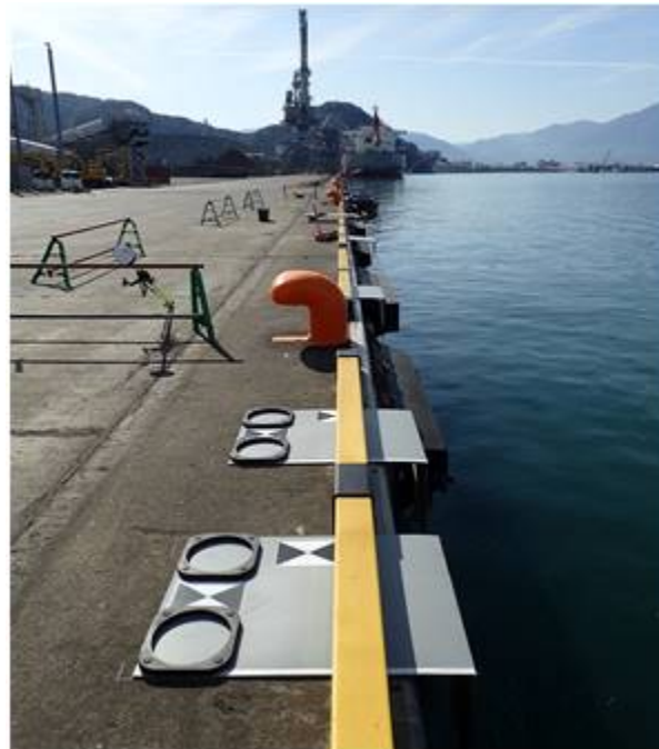
図-3.2 岸壁模型の設置状況（変位後） （模型の所定変位量は手前から水平5、10、20、50cm、鉛直16cm）
