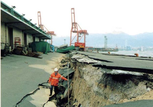
図-2.2 重力式係船岸の被災事例 (1995年兵庫県南部地震) 5)
