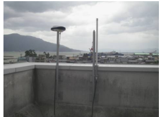
(b) 基準局 (左: GNSS アンテナ, 右: 無線アンテナ)
