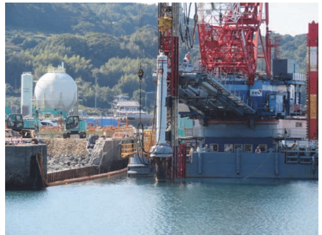
写真-4 衝撃载荷試験の実施状況
