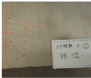
A1-P1 : G2 桁 (海側) (仕様 B)
