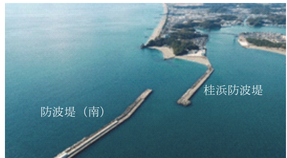
写真-2.3.2 高知港防波堤
