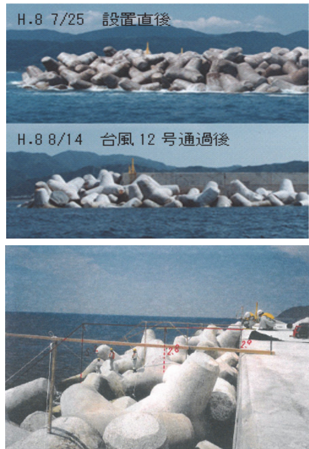
写真-1.1 消波ブロックの沈下量調査
