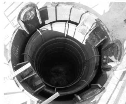
写真-6.1 架設後の杭頭部
