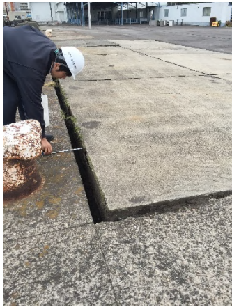
写真-5.7 石垣地区第二埠頭岸壁 (-5.5m) 南側の目地の開きと傾斜計による測定状況 (2016年4月18日撮影)
