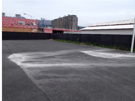
写真-5.3 石垣地区第三埠頭岸壁（-12m）エプロン背後の駐車場での3箇所の液状化痕（2016年4月18日撮影）
