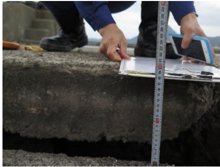
写真-5.7 石垣地区第二埠頭岸壁 (-5.5m) 南側の目地の開きと傾斜計による測定状況 (2016年4月18日撮影)
