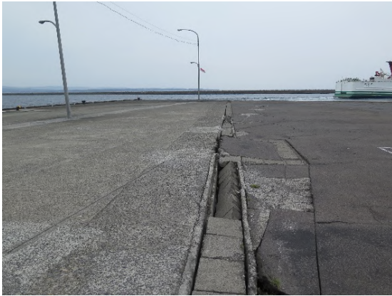
写真-5.6 石垣地区第二埠頭岸壁 (-5.5m) 中央部の U 字溝に見られた変形・段差 (2016年4月18日撮影)
