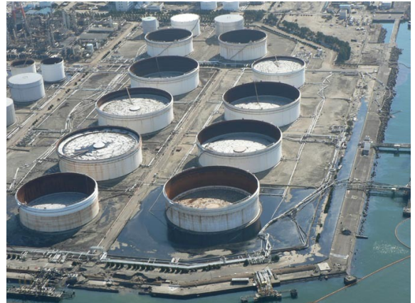
図-1.1: 震災が発生した際に製油所が被災を受けた例（仙台市消防局撮影）
