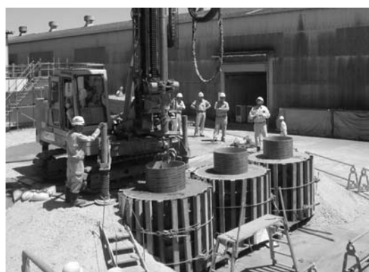
図-6.35 水平載荷試験体作製（改良杭施工）
