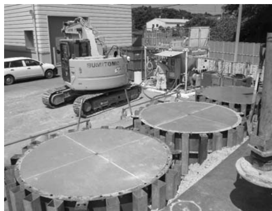
図-6.34 水平載荷試験体作製（改良杭施工前）
