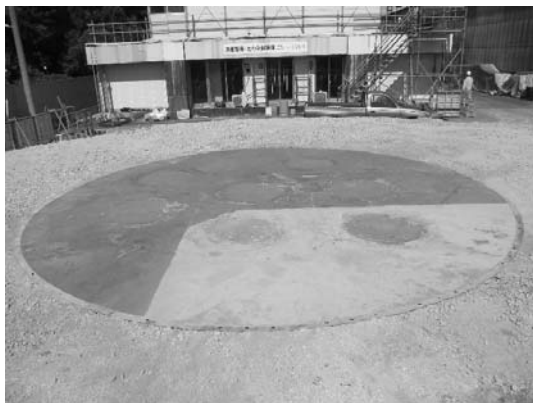
図-6.21 改良杭施工後不陸整正状況
