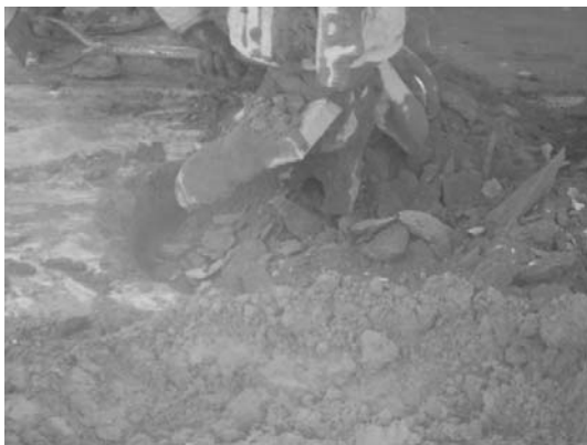
図-6.23 表層改良地盤掘削状況
