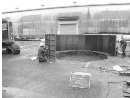
図-6.14 模擬地盤作製状況(型枠組立)
