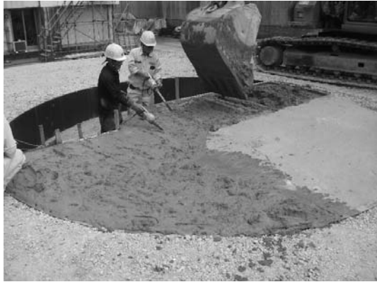
図-6.17 表層改良の施工状況
