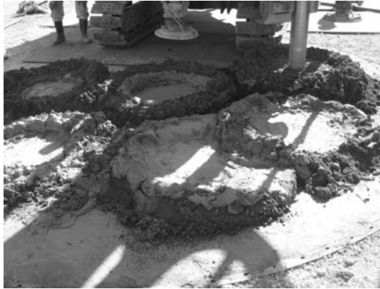
図-6.20 改良杭施工状況
