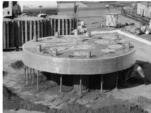
図-6.24 改良体（表層改良，改良杭）杭取出し状況
